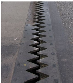
Obr. 1: Detail na práh, který můžete v různých konstrukčních provedeních nalézt na koncích všech větších mostů. Dovoluje, aby se v závislosti na teplotě mohl most roztahovat a stahovat, aniž by se poškodil.
